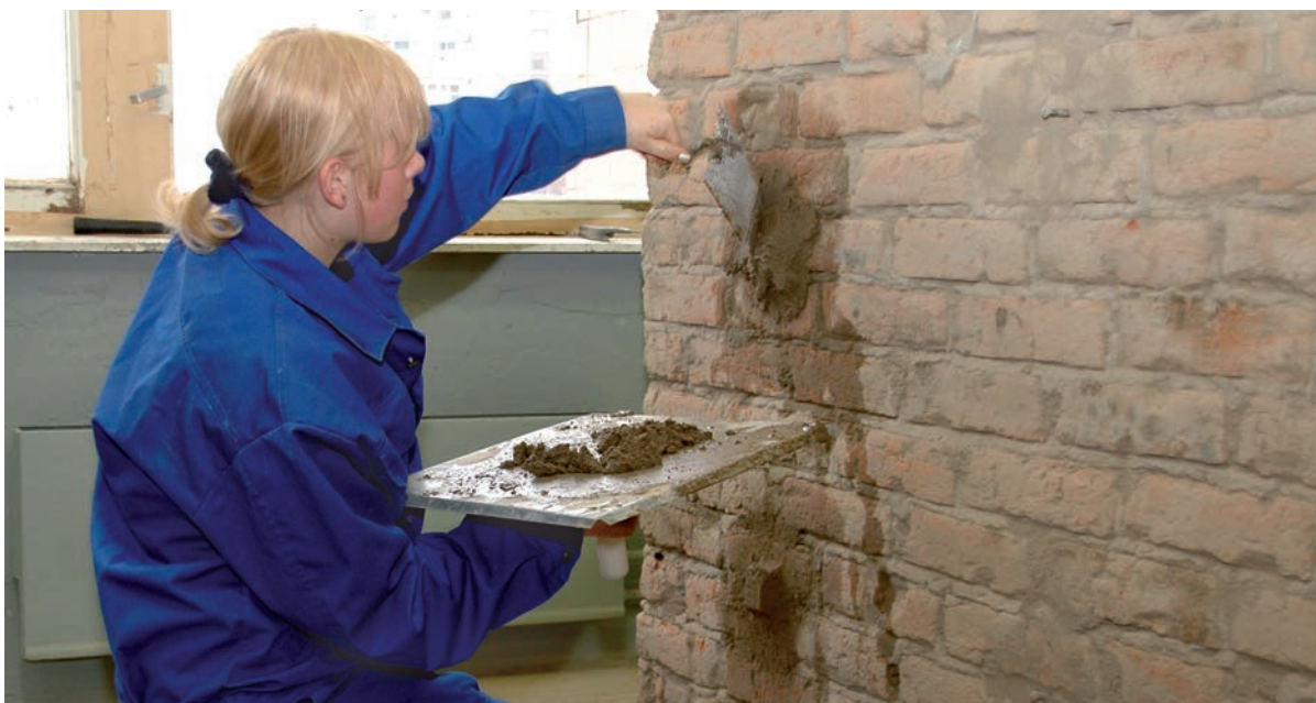
Berufsschule „Baucollege Nr. 12“ in Moskau, die mit Hilfe der Handwerkskammer Düsseldorf aufgebaut wurde – angehende Fliesenlegerin bei einer praktischen Übung
