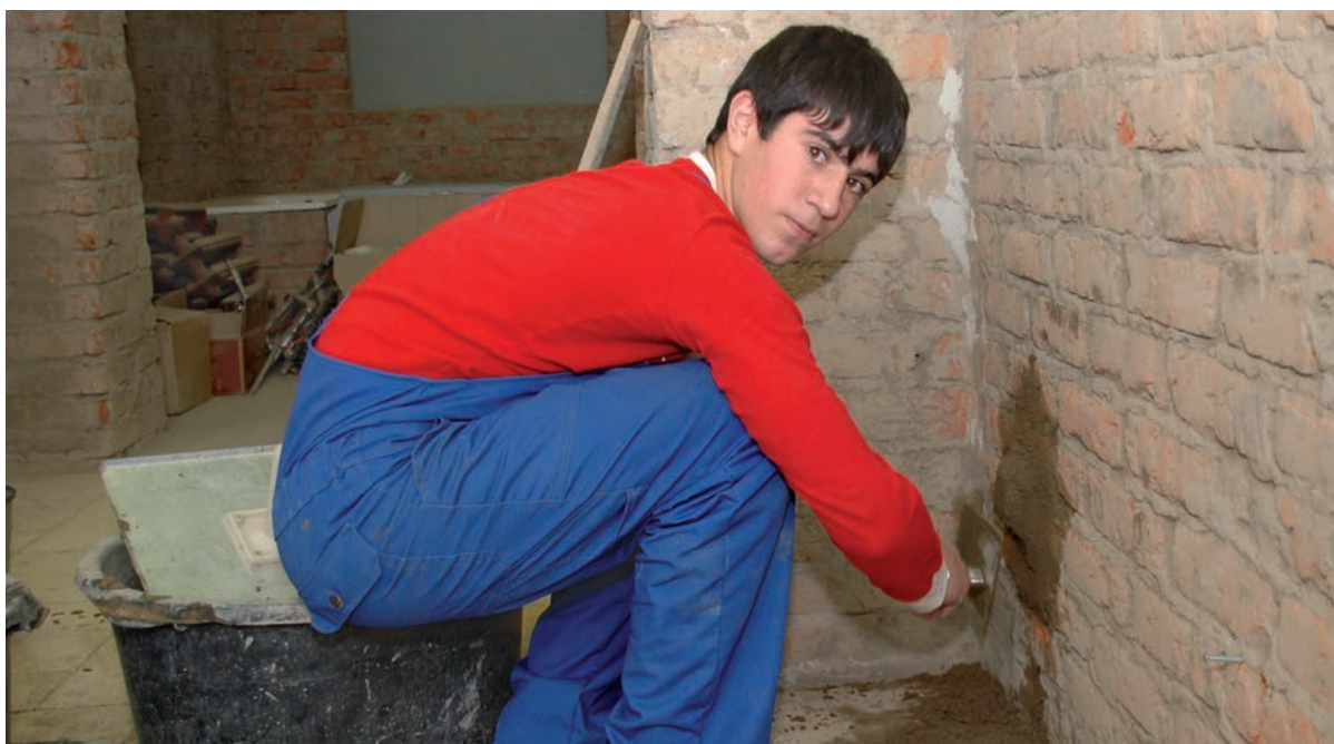
Berufsschule „Baucollege Nr. 12“ in Moskau, die mit Hilfe der Handwerkskammer Düsseldorf aufgebaut wurde – angehender Bauhandwerker bei einer praktischen Übung
